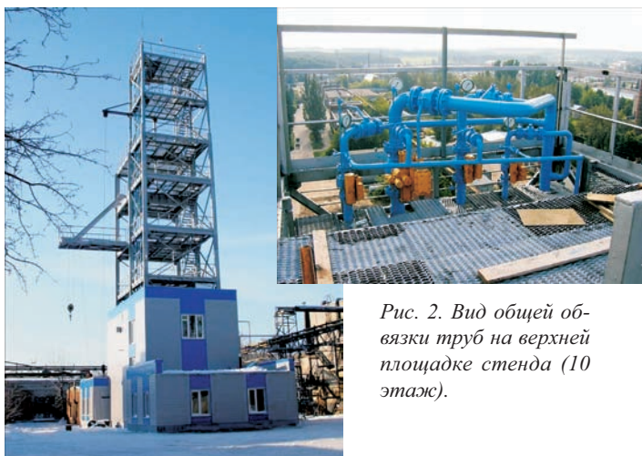
Рис. 1. Стенд по отработке технологий эксплуатации газовых скважин на поздней стадии разработки (внешний вид).
